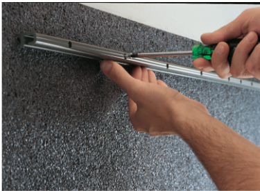
1. Kunststoffschiene an der Wand befestigen...
